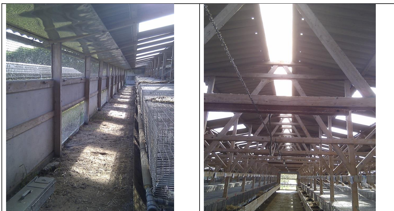
Figur 2. Billede af ventilationsåbninger i minkhaller. Billedet til venstre viser åbninger i hallens sider, mens billedet til højre viser kipåbningen på langs af hallen.
