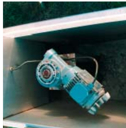
Trækstation til jordsneglen er monteret i en let tilgængelig brønd.
