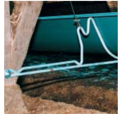
Ny bæring i bukket galvaniseret jern (Farm B).
