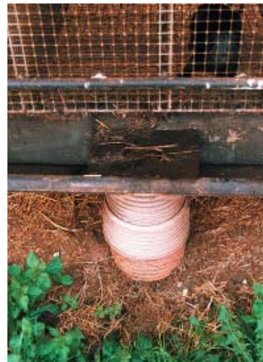
På farm A er faldstammerne lukket med et betondæksel.
