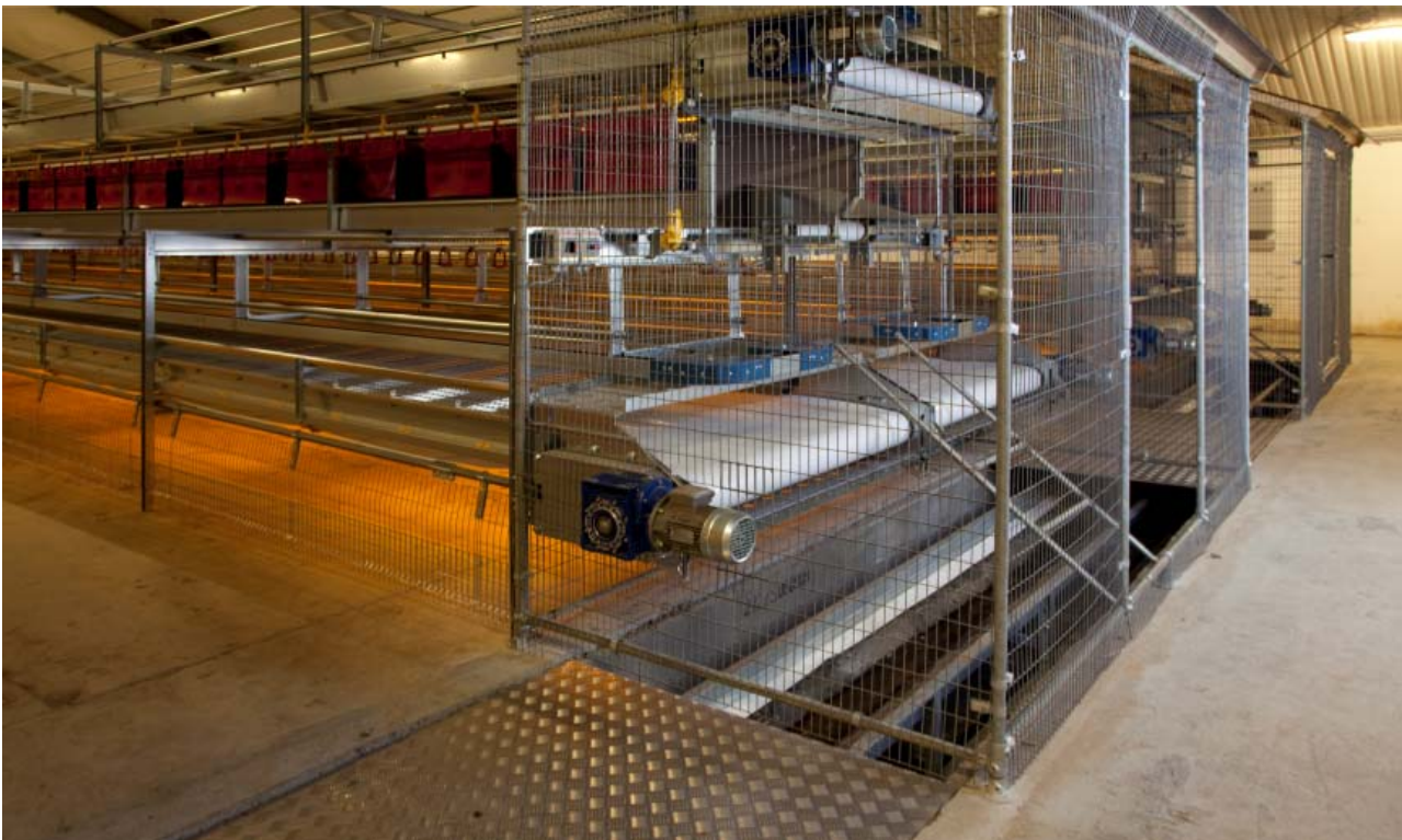
Figur 4. Gødningsbåndene trækker gødningen til enden af anlægget.
