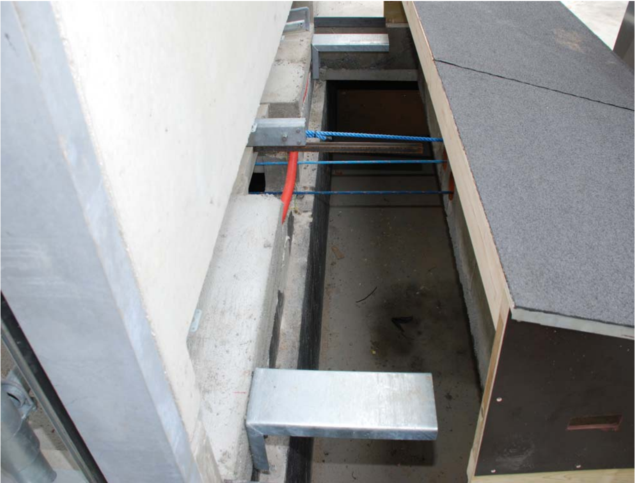
Billede 2. Udendørs tværkanal med aftagelig overdækning.
