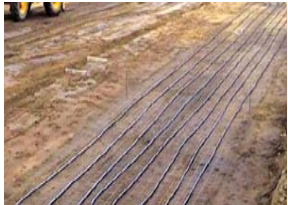
Figur 2: Eksempel på placering af køleslanger i bunden af en kommende gyllekanal.
